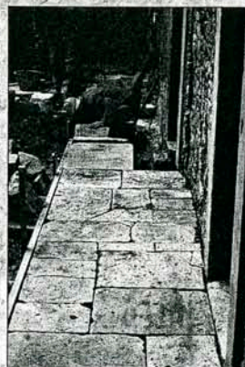
4. Posa dei tavelloni in cotto per la realizzazione di una ventilazione con andamento nord-sud. 5. Canale di ventilazione esterno perimetrale. Si noti il recupero delle pietre per la realizzazione della pavimentazione esterna.
