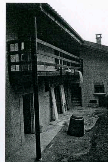
Una vista della facciata della casa prima dell'intervento di recupero e a lavori quasi ultimati.
