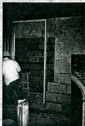
11. Realizzazione di nuovi tavolati addossati alla struttura principale per il passaggio delle tubazioni di adduzione, ventilazione e scarico.
