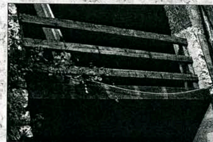
6. Alcuni travicelli del tetto sono stati riutilizzati nella realizzazione di questa nuova protezione della loggia. 7. Il "capomastro" Giovanni durante la delicata fase di stesura del manto di tavelle. 8. Le travi dismesse del tetto (in parte bruciate da un precedente incendio) sono state datate e riutilizzate per l'orditura principale del solaio della loggia. 9. Recupero delle tavole di cotto del tetto. Si noti la parte centrale della precedente orditura del controsoffitto, lasciata per la realizzazione di un soppalco. 10. Una pietra di corso è stata lavorata e impiegata per un "nuovo uso".
