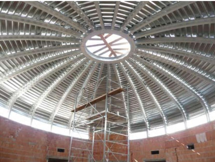
Fig. 2.67 – Vista interna della struttura della cupola prima del rivestimento di finitura.
