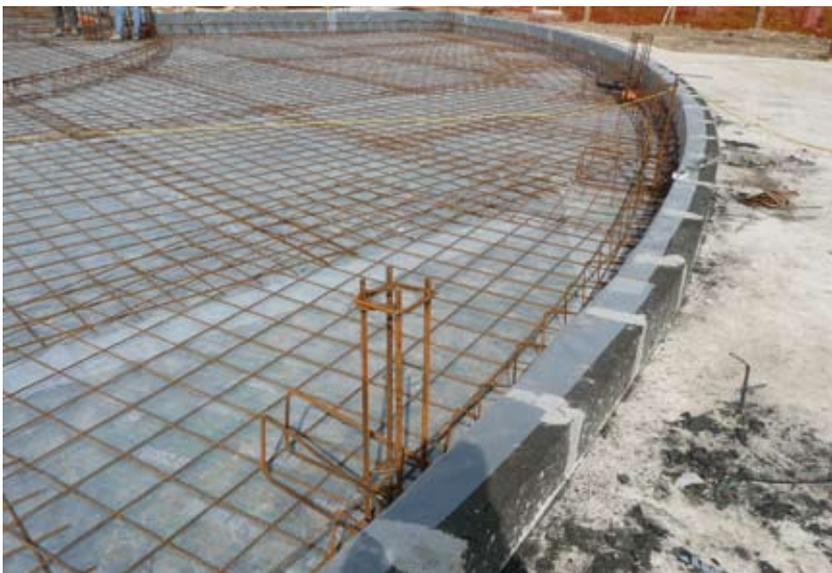
Fig. 2.61 – Dettaglio dell'isolamento termico sottoplatea.
