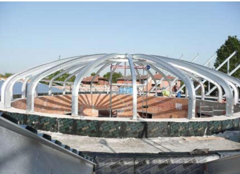
Fig. 2.66 – La struttura metallica della cupola.
