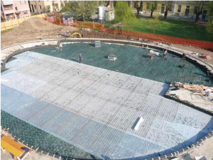
Fig. 2.59 – Fase conclusiva di posa dell'isolamento termico sottoplatea di fondazione.
